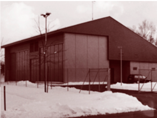
EKT Unterwerk Neu-Münchwilen an der Hofenstrasse
