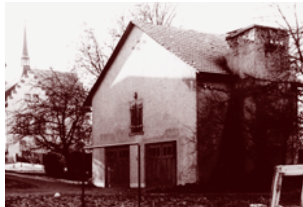
Turbinenhaus der J. Heitz & Cie. beim Zellwegerhaus
