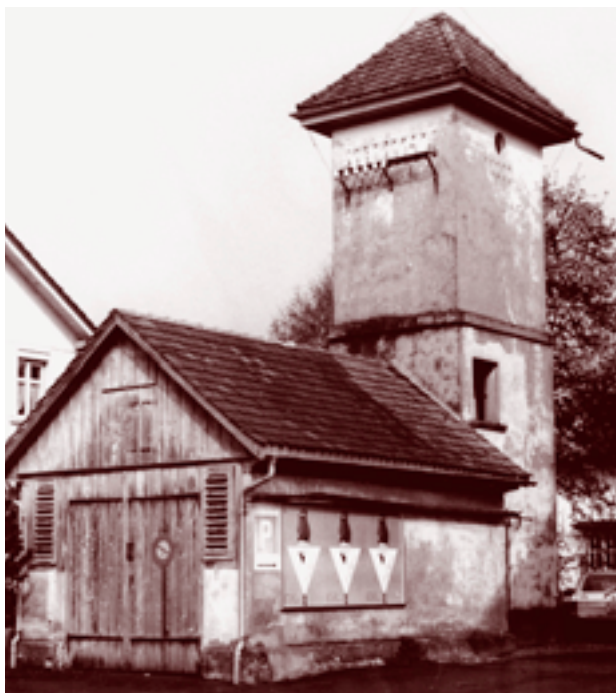
Das 1994/95 abgebrochene Transformatorerntürmchen mit Spritzenhaus in St. Margarethen
