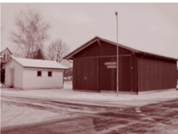
Trafostation Murgtal mit Lagerhalle
