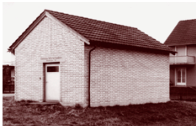
Trafostation Hörnlistrasse nach ihrer Fertigstellung im Jahre 1959
